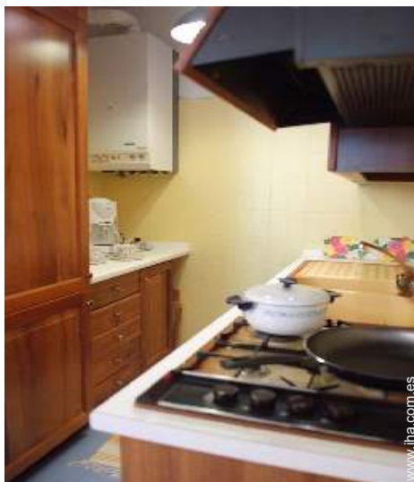
cocina de gas
