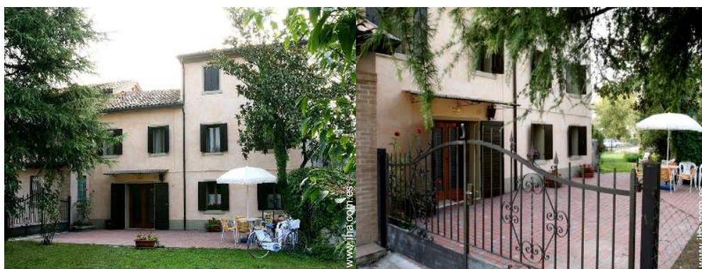
vista de conjunto
