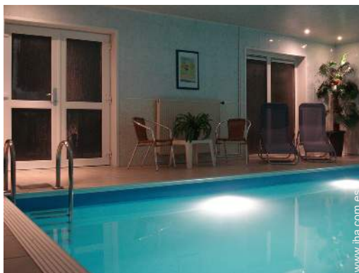
sistema de iluminación
