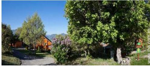
vista de conjunto
